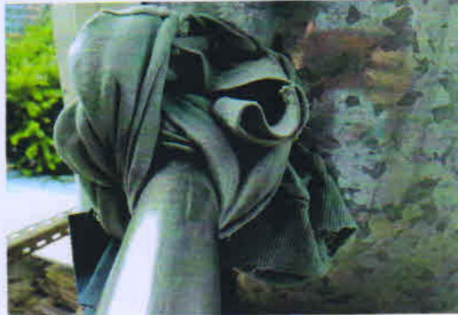
02 木屑废气排放口
