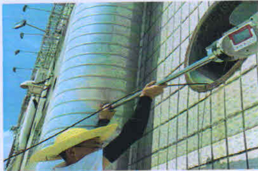
01 喷漆漆废气排气筒废气排放口
